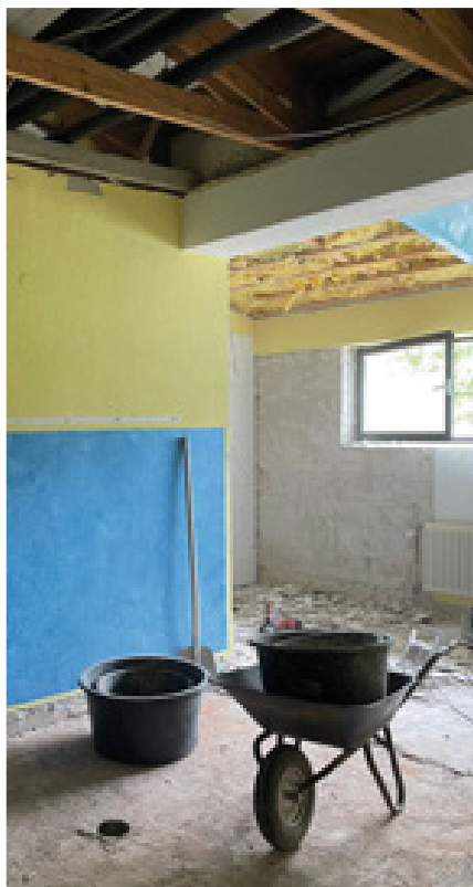
Abriss Decke und Bodenfliesen in den Umkleieräumen
