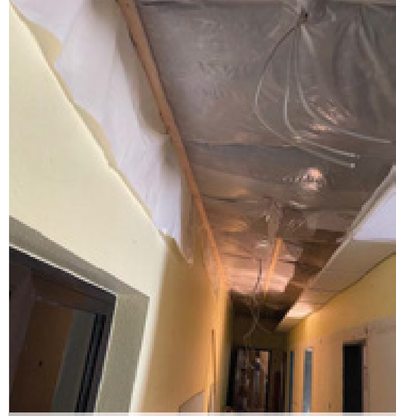
Vorbereitung des Einbaus der neuen Decke
