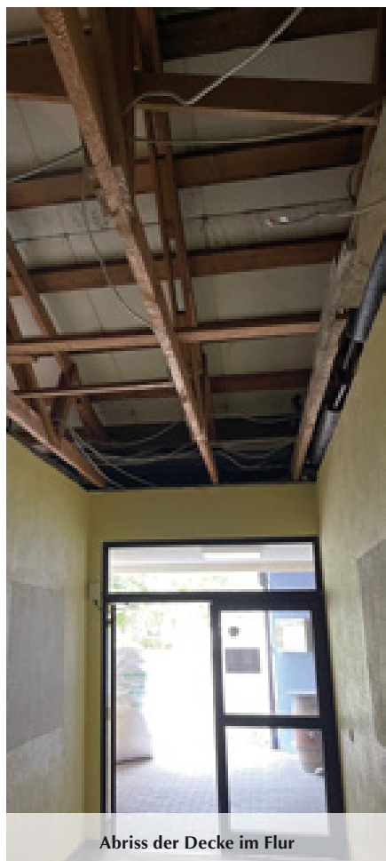
Vorbereitung der neuen Elektroinstallationen in den Umkleieräumen
