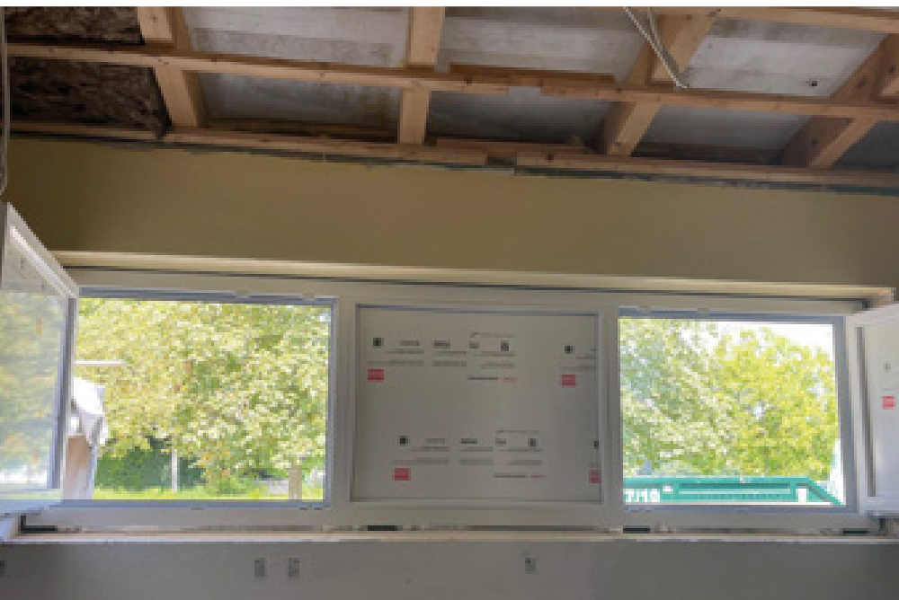
Einbau der neuen Fenster
