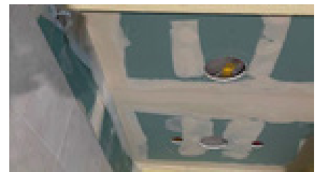
Neue Decken mit Lüftungslöcher
